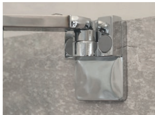
Beispiel: Montage 45°-Stabilisator am Fliesenrand
